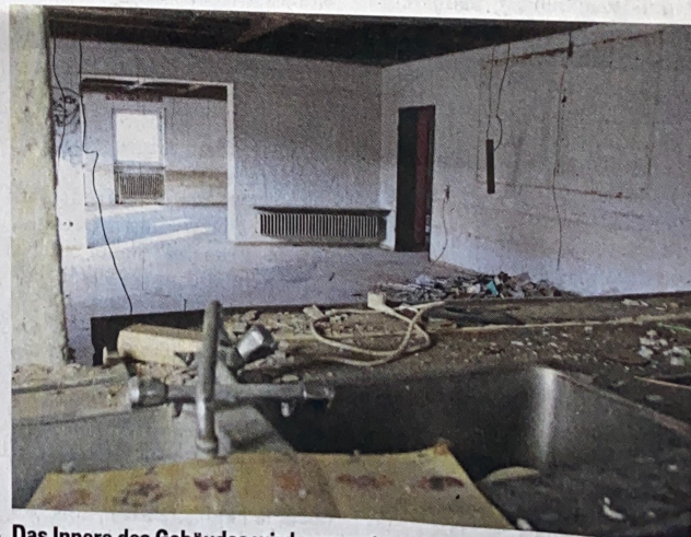
Das Innere des Gebäudes wird momentan entkernt.
